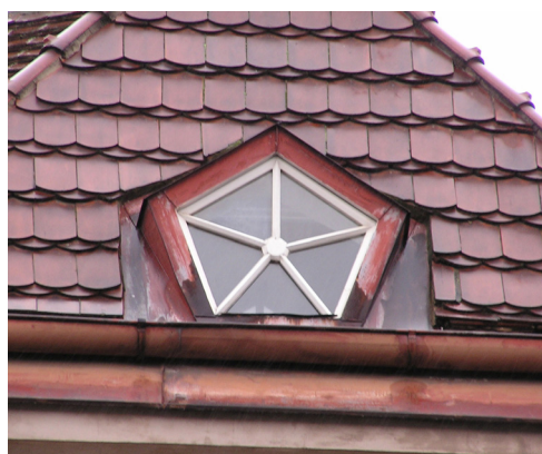
Obr. 5. Okno v Neklanově ulici
