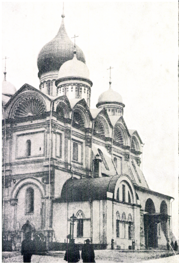
Archangelský sobor v Moskvě. s typickými zakomary, vystavěný milánským architektem v letech 1505—08.
